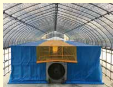
ハウス内設置
